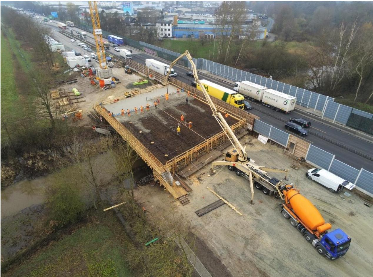
Abb. 14: Herstellung einer Brückenhälfte für den Ersatzneubau Ochtumbrücke
