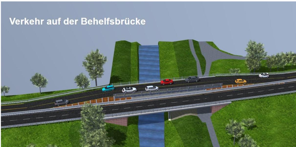
Abb. 27: Visualisierung der B75 für die Bauphase mit Nutzung einer Behelfsbrücke
