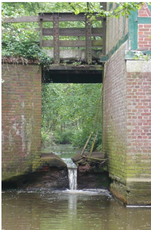
Abb. 1: Sohlabsturz am Mühlenbauwerk Brockmannsmühlen, stromaufwärts gesehen
