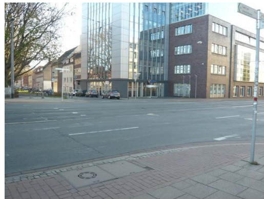
Langemarckstraße (Neustadt) Fehlende Querungshilfe im Zuge der Hauptroute Am Deich
