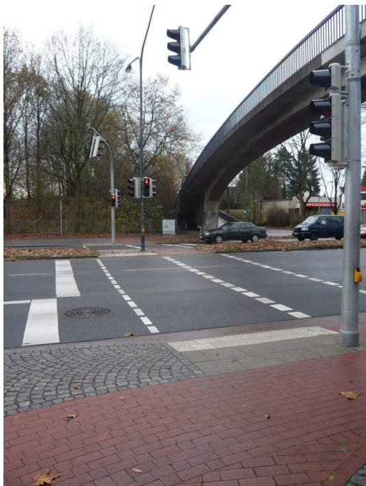
Abbildung 160: Barrierefreie Fußgängerampel als Alternative zur Überquerung der Richard-Boljahn-Allee
