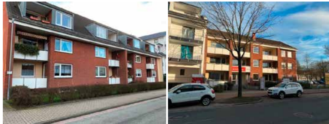
Abbildung 10: Ehemaliger geförderter Bestand der Brebau GmbH in der Walter-Flex-Str./Hammerbecker Str. in Bremen-Vegesack
