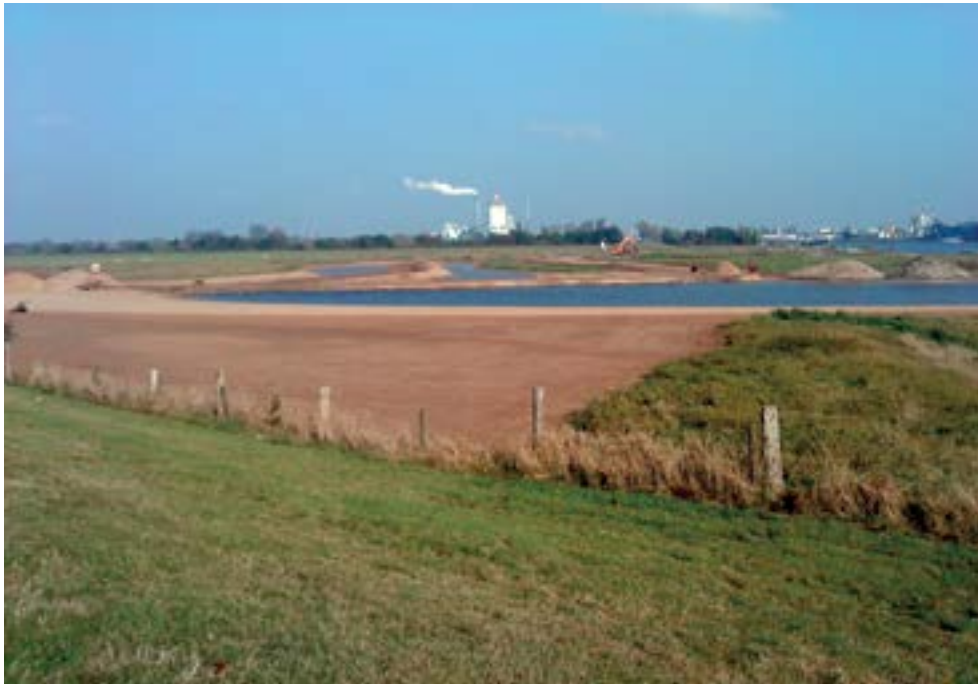
Abb. 34: Bauphase der Auenrevitalisierung der Weser in Habenhausen (Umsetzung 2014, Projektträger bremenports).
