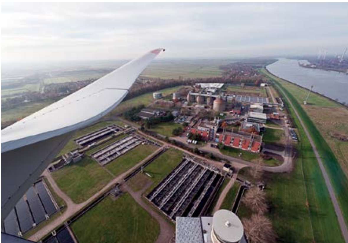
Abb. 40: Kläranlage Seehausen (Quelle hanseWasser)
