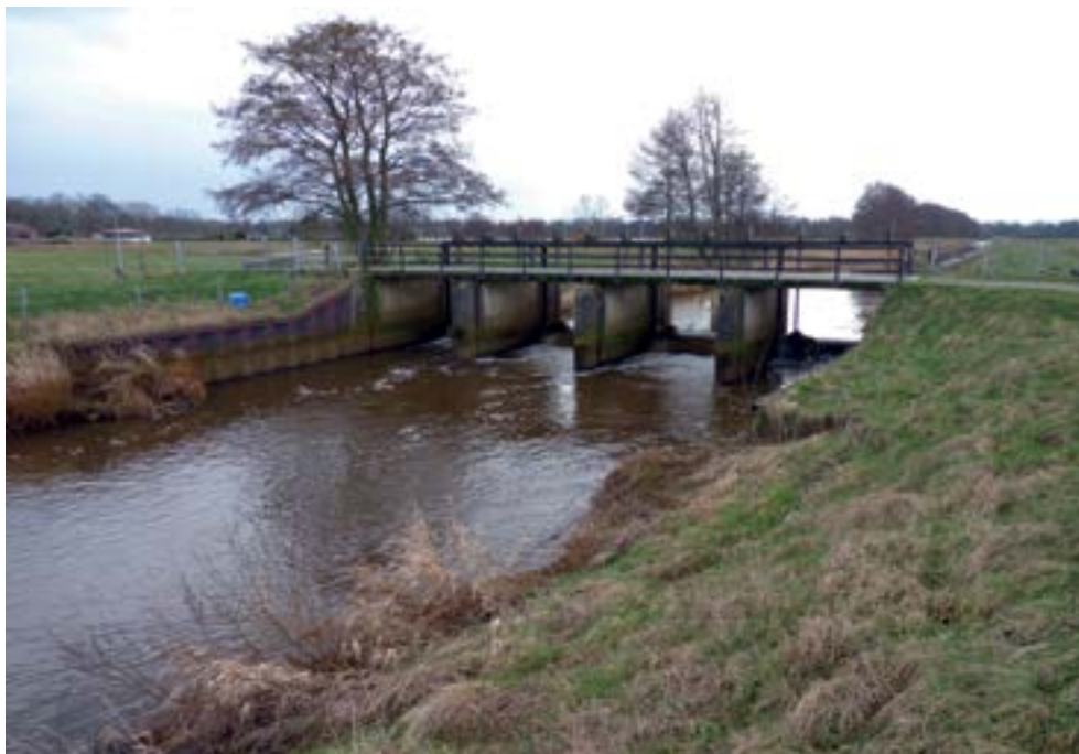
Abb.35: Flügger Stau von stromabwärts betrachtet
