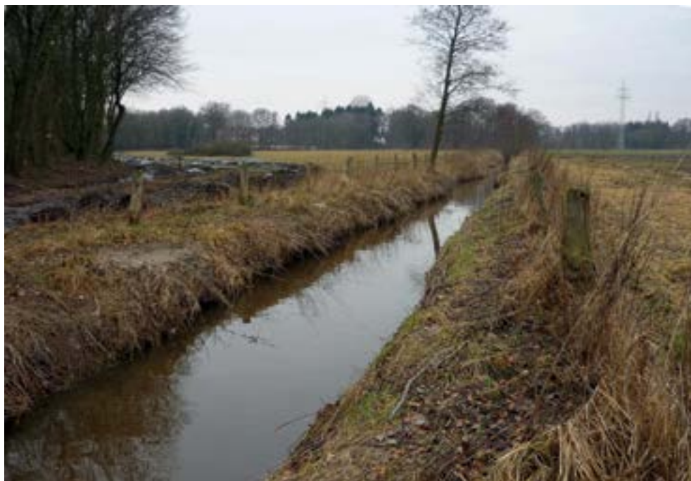
Abb. 42: Blumenthaler Aue Mittellauf, relativ naturfernes Trapez- bzw. Unterhaltungsprofil. Potentieller Bereich für die LAWA-Maßnahmen Nr. 72 oder Nr. 70. Ebenfalls sollte hier geprüft werden, ob die Unterhaltung reduziert/optimiert werden kann (LAWA Nr. 79).
