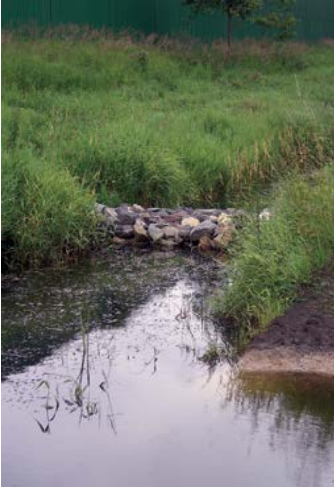
Abb. 32: Durch Abtrennung mit Wasserbau-steinen wird der alte Verlauf des Embser Mühlengrabens oberhalb Bultensee zum Altgewässer.
