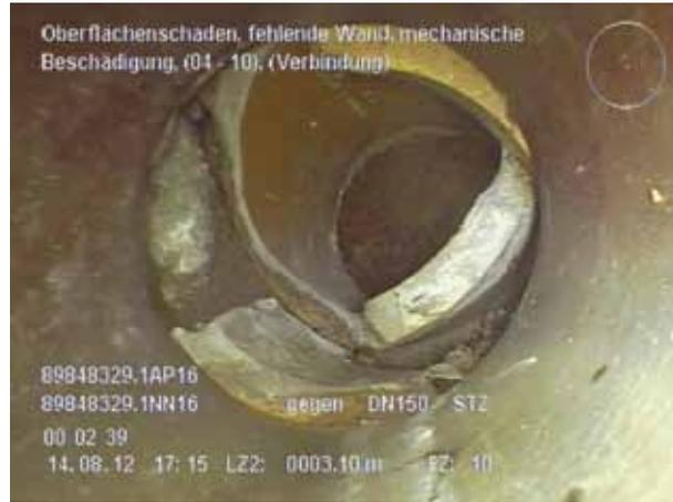
**Defekte Leitung – Schäden durch fehlende Wand**
