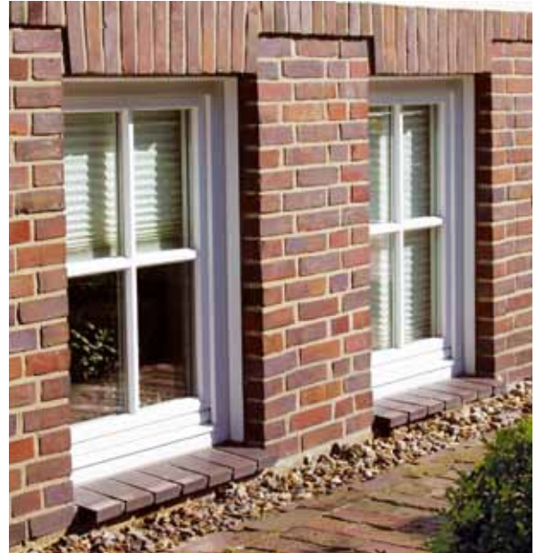
Kiesstreifen am Gebäudesockel zum Schutz der tiefliegenden Fenster.
