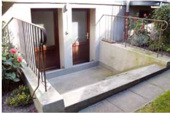
Doppelt geschützter Kellereingang.
