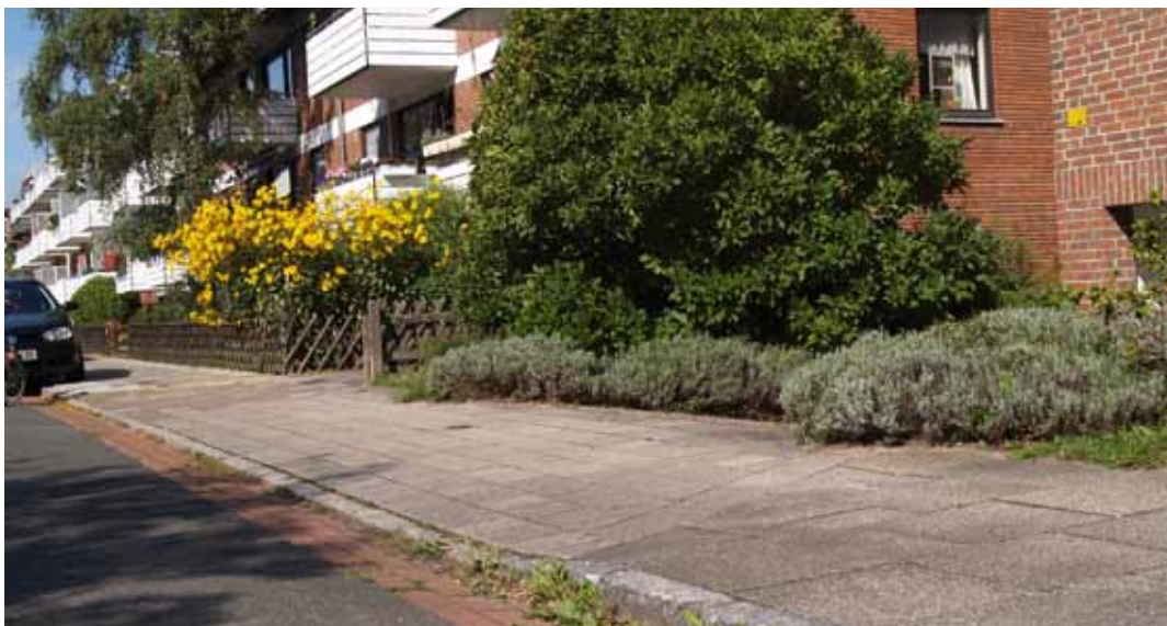
Bodenschwelle vor einer Tiefgarage.
