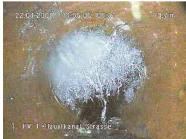
**Defekte Leitung – Schäden durch Wurzeinwuchs**
