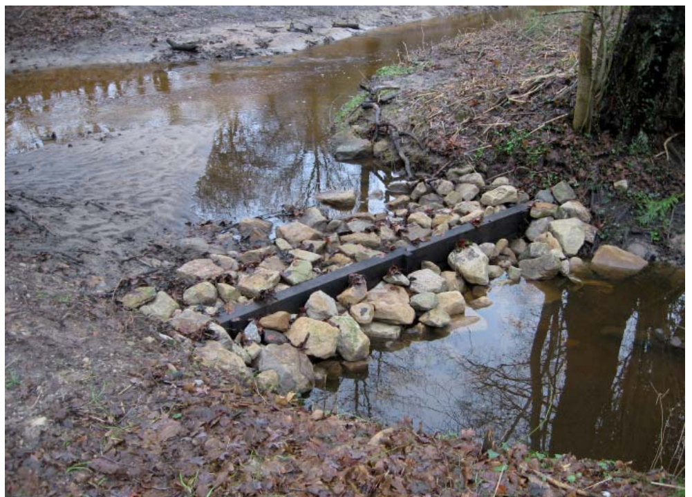
Schwelle im alten Verlauf der Beckedorfer Beeke, die den Zulauf in den neuen Verlauf sicher stellt
