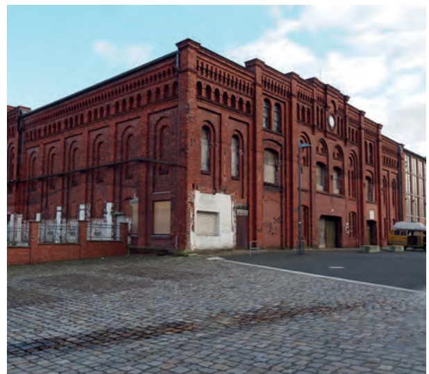
Abb. 8 Leerstehende historische Gebäude im Kämmerei-Quartier
