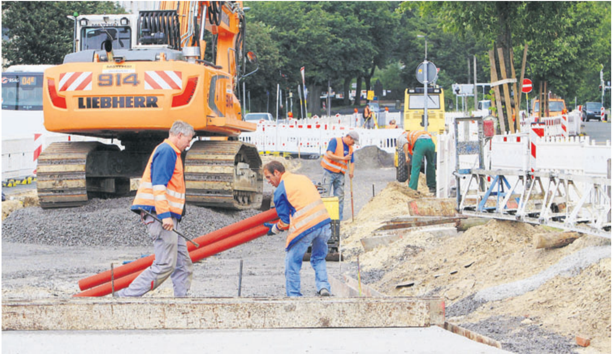
Auf dem Niedersachsendamm verlegt die BSAG zwischen Habenhauser Landstraße und Sielhof 550 Meter neue Gleise.
