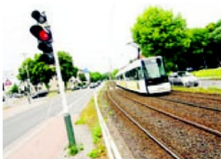
Morgen beginnt die sechswöchige Gleiserneuerung am südlichen Niedersachsendamms. Foto: Lucker
