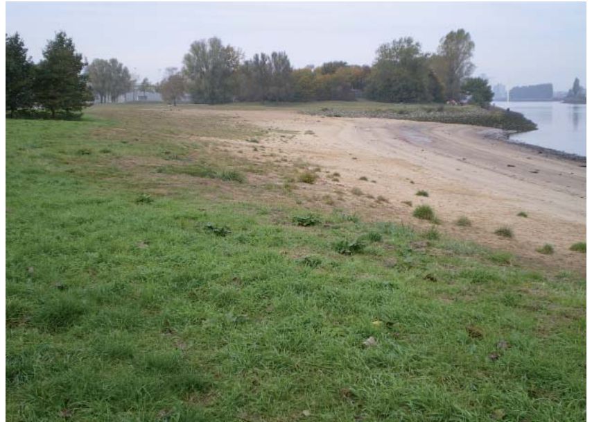
Heutiger Zustand nach Durchführung der Maßnahme
