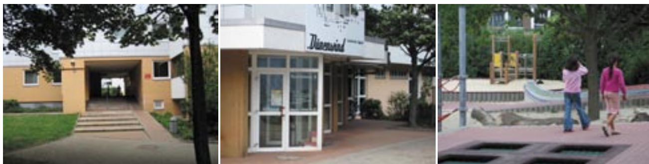
Foto 3, 4 und 5: Ein Eingang in den Innenbereich des ringförmigen Hochhauses; Bewohnertreff „Dünenwind“; Kinderspielplatz im Schwerpunktgebiet
