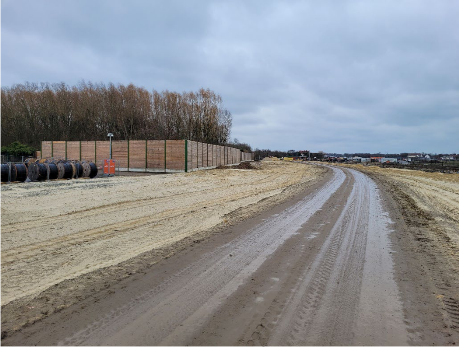
A 281 BA 2/2: Trassenvorbereitung in Randlage zum Flughafen mit schon realisierter Lärmschutzwand
