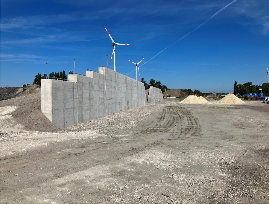
A 281 BA 4: Herstellung der Stützwand im Bereich der Schlackenkippe zum Schutz der zukünftigen Autobahn
