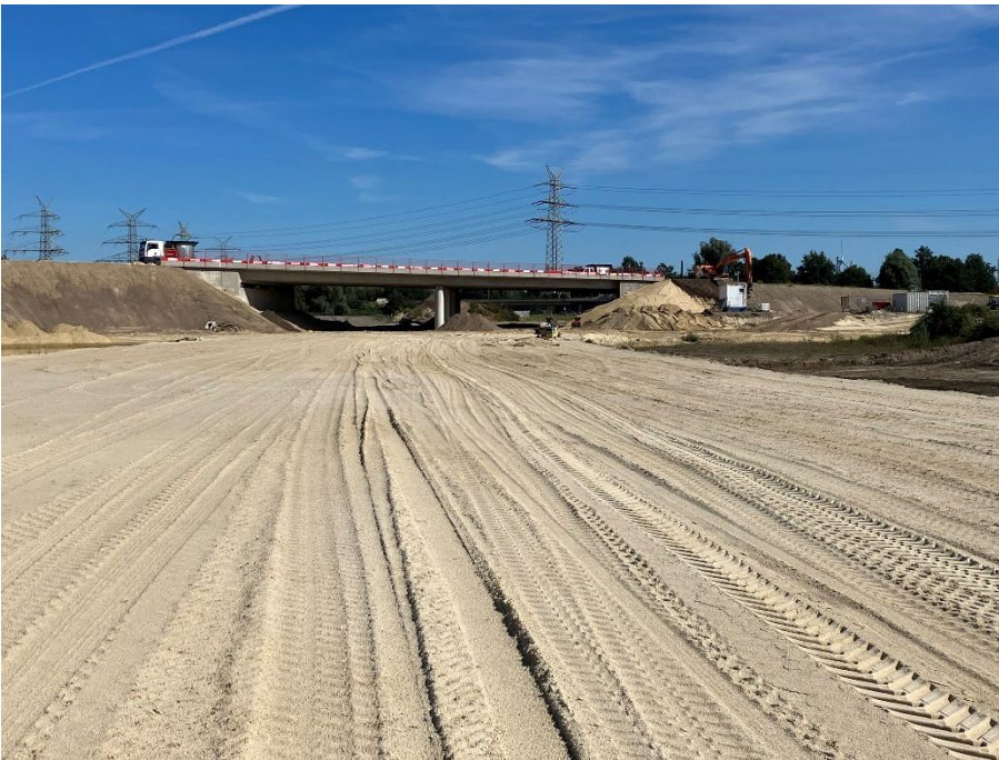
A 281 BA 4: Trasse Nord mit Brücke Carl-Benz-Straße und Herstellung der Kampfmittelfreiheit
