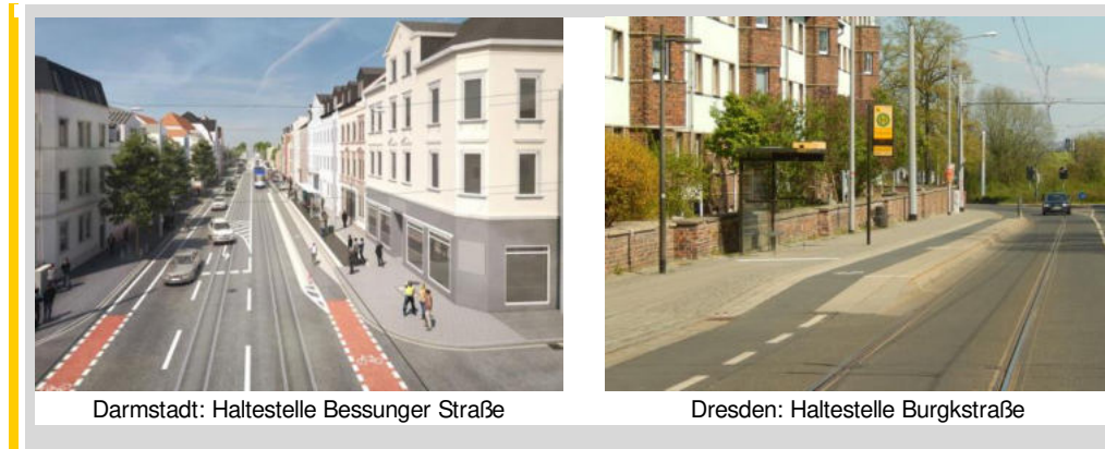
Abbildung 5.5: Praxisbeispiele Haltestelle mit angehobener Radverkehrsanlage
